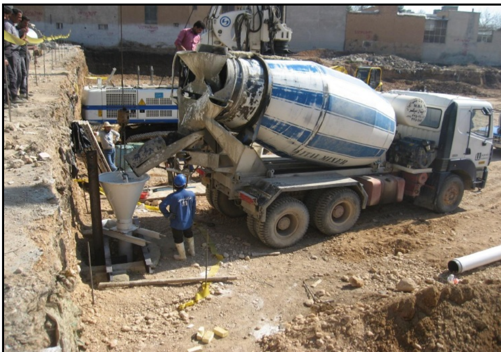
(۵) بتن ریزی شمع سازه نگهبان
