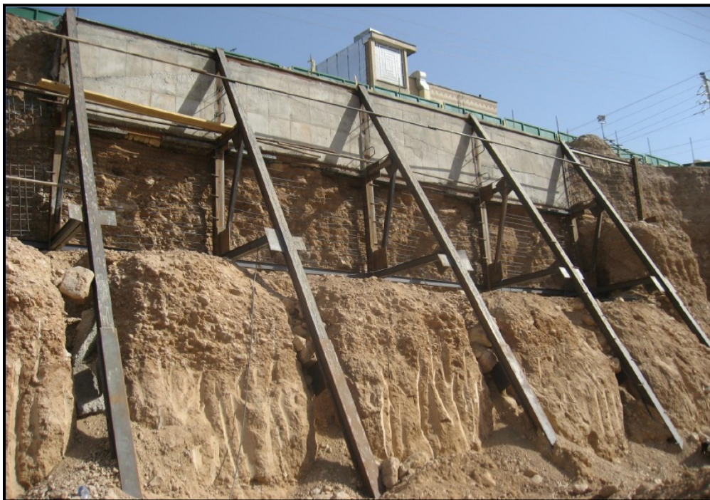
(۱۰) آرماتوربندی، قالب بندی و بتن ریزی
