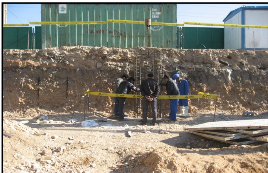
۳) نصب سبد آرماتور شمع سازه نگهدار
