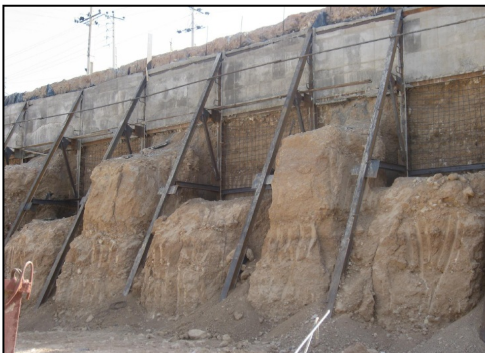
(۱۱) خاکبرداری مرحله به مرحله و تکمیل اجزاء سازه نگهدارنده
