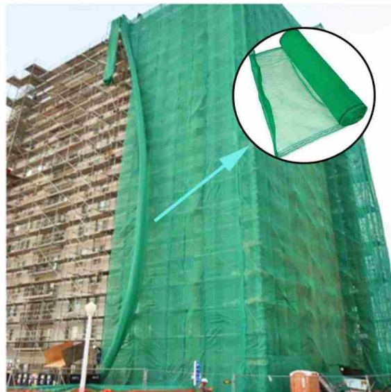
شکل ۳۰- نصب لفاف مقابل دهانه‌های باز ساختمان
