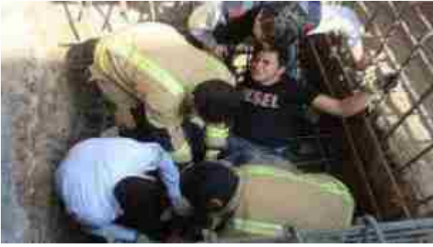
سقوط کارگر آرماتوربند - عدم استفاده از تجهیزات حفاظت فردی در کار در ارتفاع
