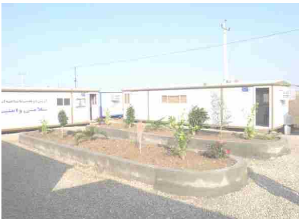
ایجاد محل مناسب به عنوان دفتر کارگاه در سایت پروژه
