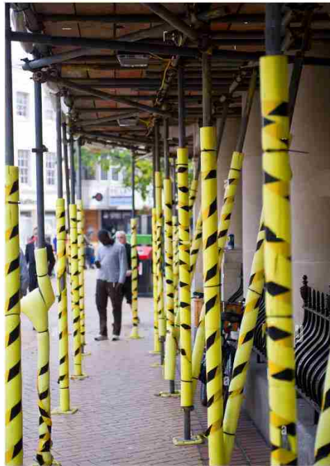
شکل ۲۱- استفاده از پوشش اسفنجی برای داربست‌ها
