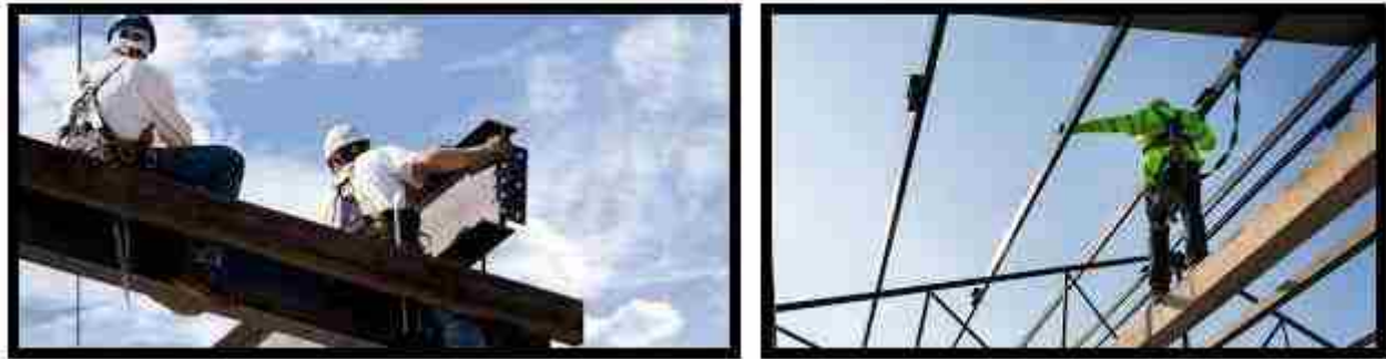
شکل ۹۱- استفاده از تجهیزات ایمنی در نصب اسکلت فلزی
